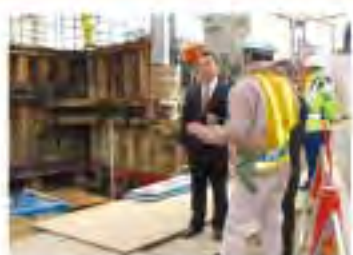
道路通りのガード拡張工事が進展、 市民のための都市計画実現をめざす
