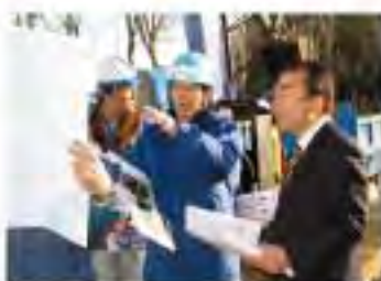
治水対策で都の「雨水整備クイック プラン」工事を視察(江古田公園)
